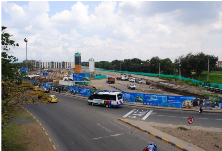
Panorámica del sector de SAMECO, en proceso de modernización.
