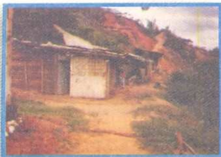
Asentamiento de la Choclona ubicado en la ladera del río. Se puede observar su alta vulnerabilidad.
